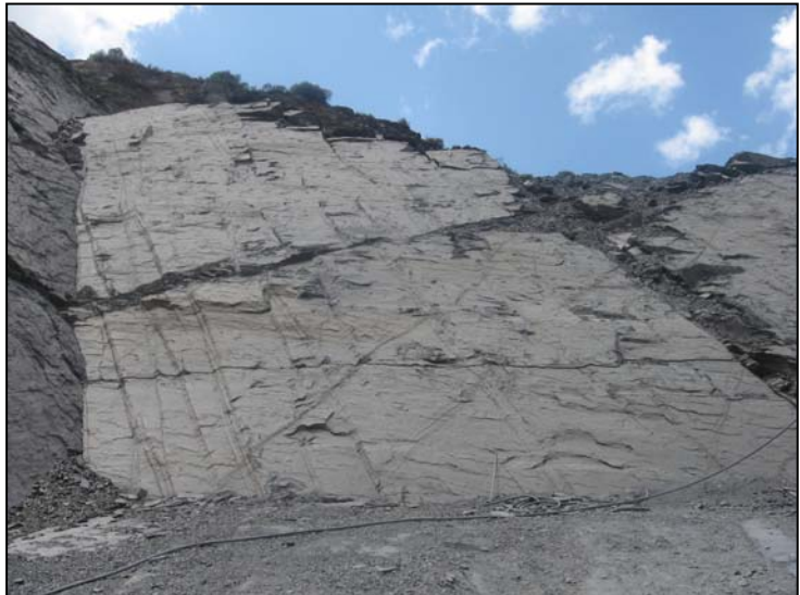
Fotografía 4.2.6.11.2.- Talud mostrando la abundancia y continuidad de kink-bands en un sector de la Fm. Rozadais. afa
