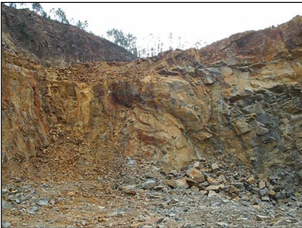
Fotografía 4.3.2.1.3.- Aspecto del frente en la cantera Pedra Facha. jfs
