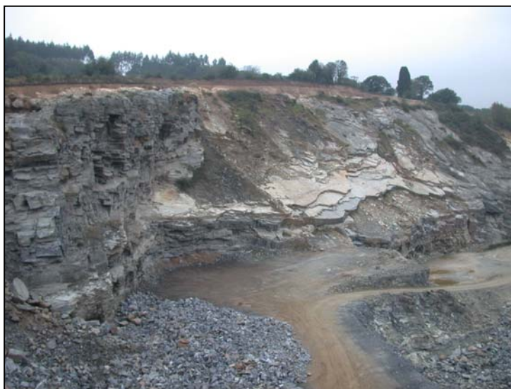
Fotografía 4.3.2.2.5.- Sector de la cantera Penas do Cal donde las calizas aparecen foliadas. jfs
