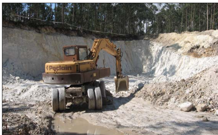
Fotografía 4.4.2.2.2.- Aspecto de las excavaciones para caolín de N o Sra. de Begoña. afa
