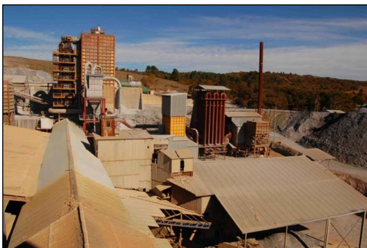
Fotografía 4.4.5.6.- Vista general de la planta de tratamiento de magnesitas. jfs
