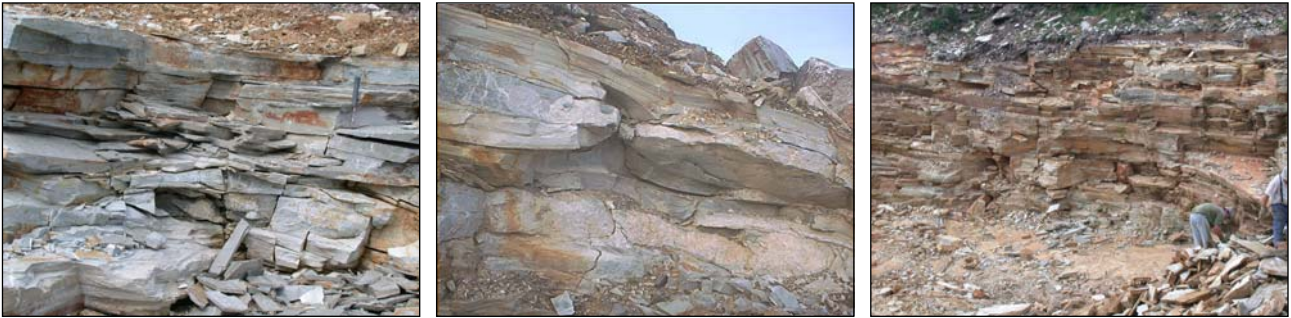
Fotografía 4.2.2.2.7.- Detalles del frente de la cantera Marisol. Parte superior - Cuarzitas blanco grisáceas con lentejones o venas de cuarzo (se arranca con explosivos) – Parte inferior. afa
