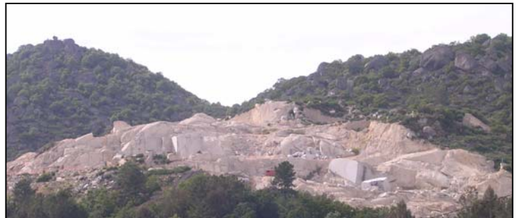
Fotografía 4.2.5.1.9.- Cantera de granito en el sector de Orega. Afloramientos de bolos tanto en la cantera como por encima de ella, puede observarse también el importante desarrollo de la arenización. mgm
