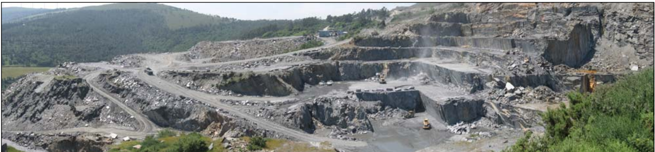
Fotografía 4.2.6.7.3.- Aspecto general de la cantera Monte Rande I. afa
