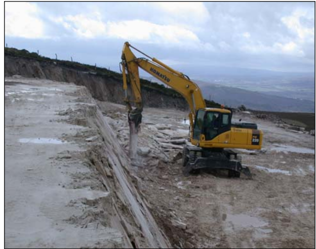
Fotografía 4.2.2.8.1.- Maquinaria extrayéndo bloque primario en la cantera Angelita. afa
