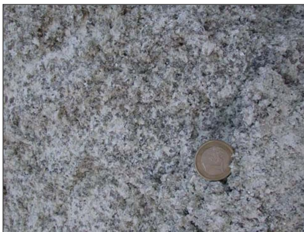
Fotografía 4.4.2.1.2.- Detalle del granito caolinizado. jfs
