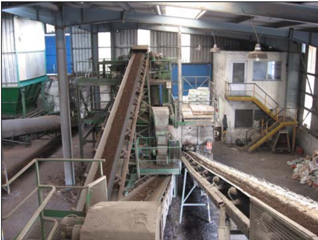
Fotografía 4.4.7.4.- Un aspecto general de la nave de elaboración de turba. afa
