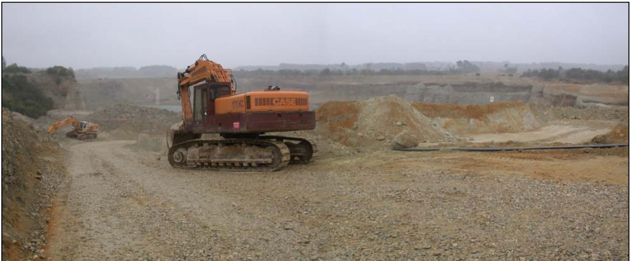
Fotografía 4.3.1.1.5. – Vista general, desde la zona de acceso, del hueco actual de extracción de la explotación Bestar con la maquinaria utilizada en las labores. jfs
