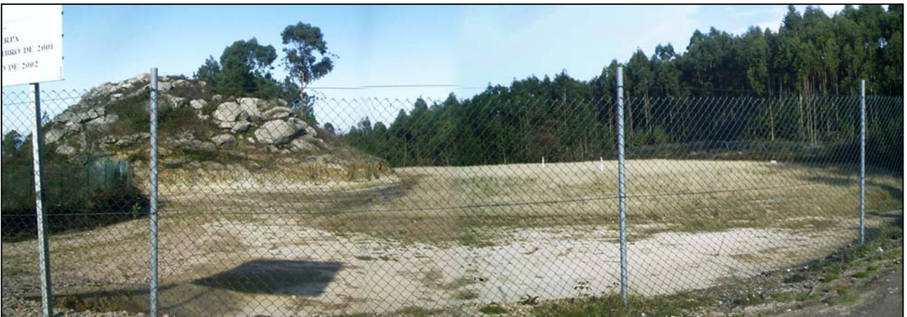
Fotografía 5.3.- Buena práctica de relleno controlado en una cantera abandonada.
