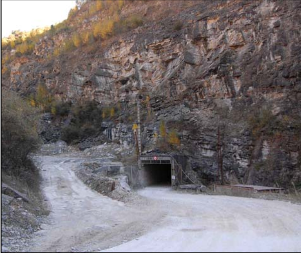
Fotografía 4.4.5.1.- Bocamina de la explotación subterránea Impensada. jfs
