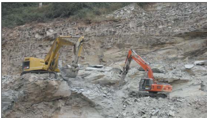
Fotografía 4.2.6.13.1- Operación de arranque de rachón y exfoliación mecánica en cantera. afa
