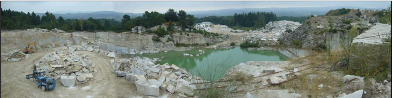
Fotografía 4.2.5.2.13.- Vista general del hueco de explotación de la cantera Santa Eulalia. jfs
