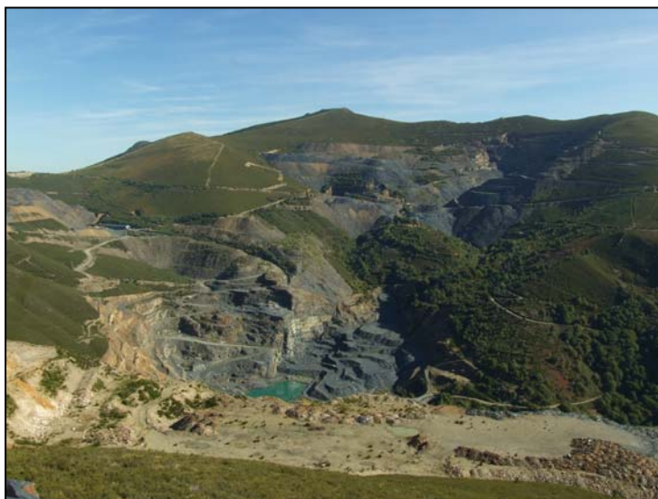
Fotografía 4.2.6.7.8.- Aspecto general de la zona de explotación de Pacios da Serra (O Courel). jfs
