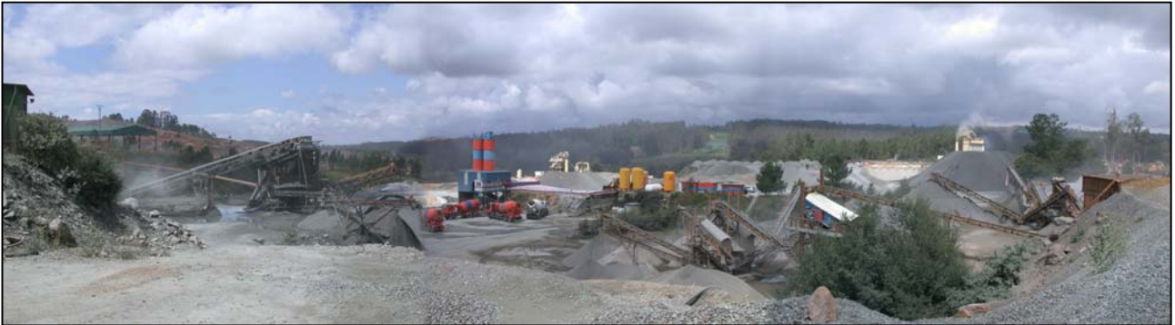
Fotografía 4.3.2.10.2.- Vista general de la zona de tratamiento de áridos de machaqueo. jfs
