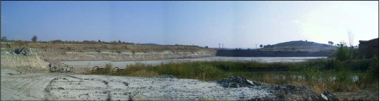
Fotografía 4.4.1.2.6.- Aspecto general de la explotación de arcillas “El Castelo”. mgm
