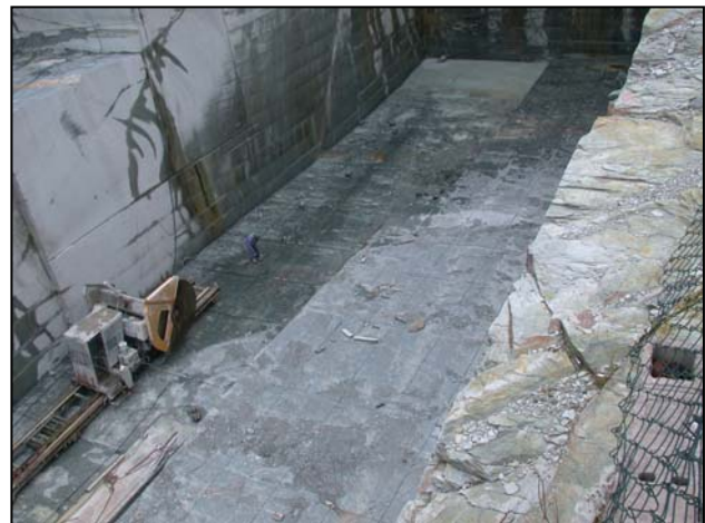
Fotografía 4.2.6.3.3.- Corte en mallas con sierra circular para bloque primario. jfs
