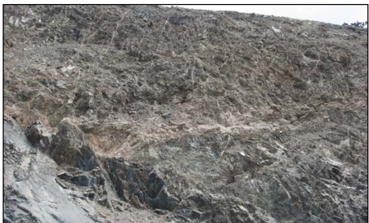
Fotografía 4.3.2.9.2.- Zona de alteración superficial. afa
