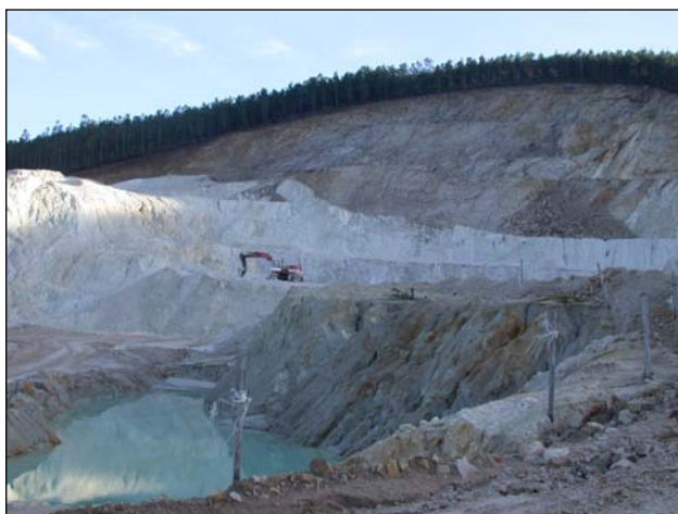
Fotografía 4.4.2.1.1.- Aspecto del frente en el hueco sur. jfs
