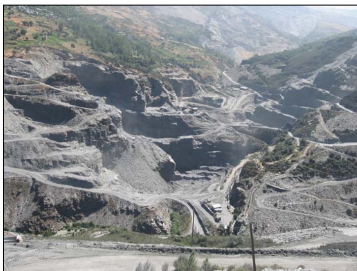
Fotografía 4.2.6.7.7.- Aspecto general de la zona de Pena Pandela a Valdesandelo. afa
