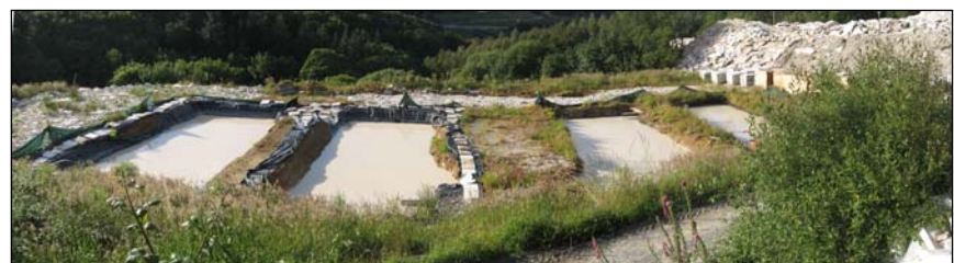
Fotografía 4.2.2.8.4.- Balsas de decantación en la cantera (Cantera Angelita). afa
