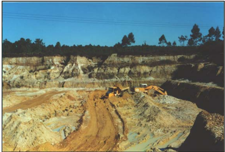
Fotografía 4.3.1.1.- Explotación de gravas y arenas en las terrazas del río Miño. afa
