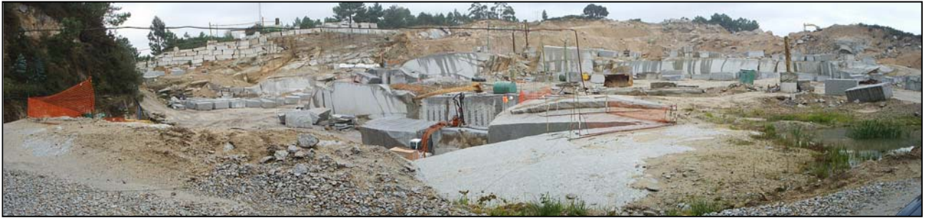
Fotografía 4.2.5.1.17.- Aspecto general de una explotación de piedra natural en el Macizo de Caldas de Reis. vga
