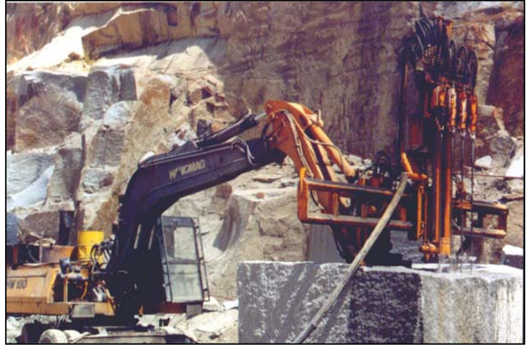
Fotografía 4.2.5.3.1.- Perforadora multimartillo utilizada para subdividir un bloque. afa
