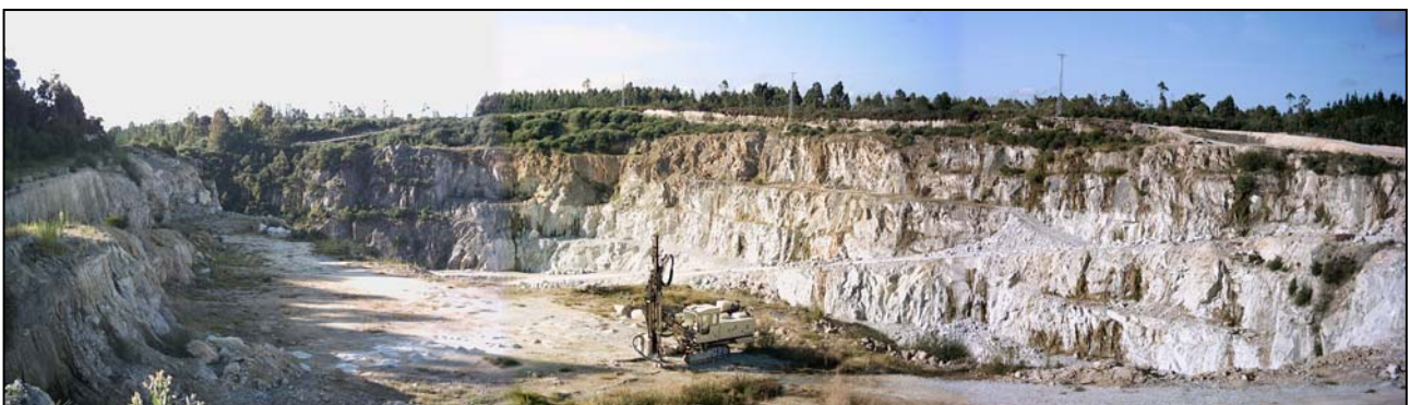
Fotografía 4.3.2.8.18. – Vista general del hueco de explotación de la cantera Montesalgueiro. jfs
