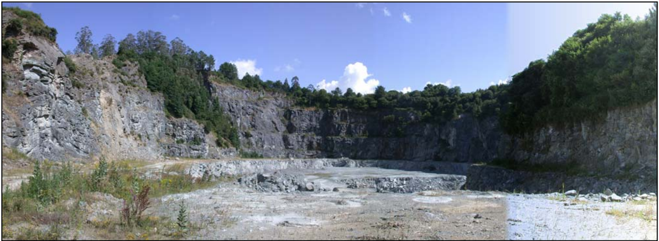
Fotografía 4.3.2.5.2.- Vista general del hueco de explotación de Portodemouros. jfs
